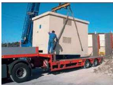
Figure 34 : Déchargement d'un poste électrique
