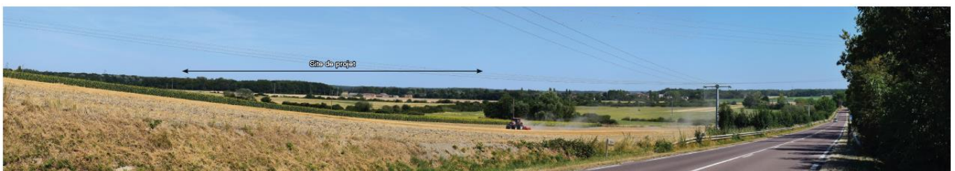
Figure 93 : Vue depuis la D619 vers le site de projet (63)
